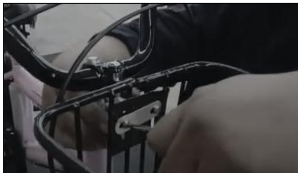
16. Colocar los tornillos de la parte superior del canasto y ajustarlos con un destornillador phillips
